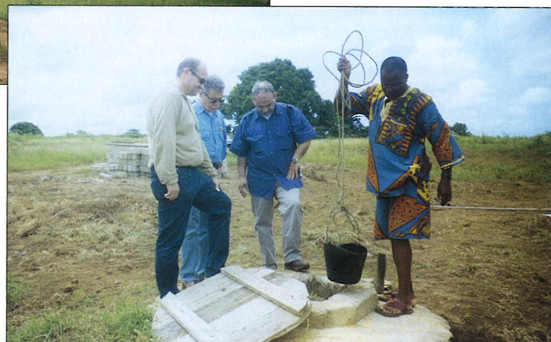
L'Accademico Angelo Comandù, con il collega ingegnere Flavio Bettoni e il Presidente Carpintieri verificano lo stato di un pozzo in prossimità del Presidio Sanitario dell'AEREC. A destra, il capovillaggio di Songon, il Deputato Barthélemy Kokoura Attoure.
